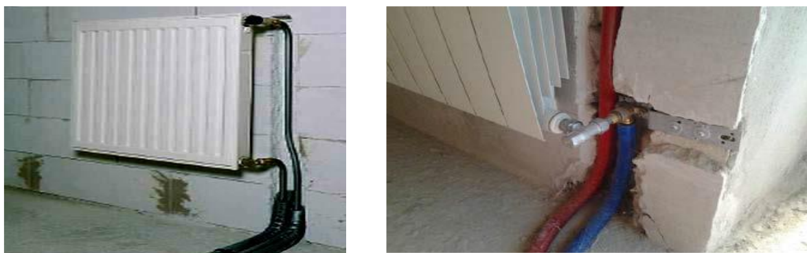
Рис. 11.12 – Варианты бокового подключения радиатора из штрабы стены
