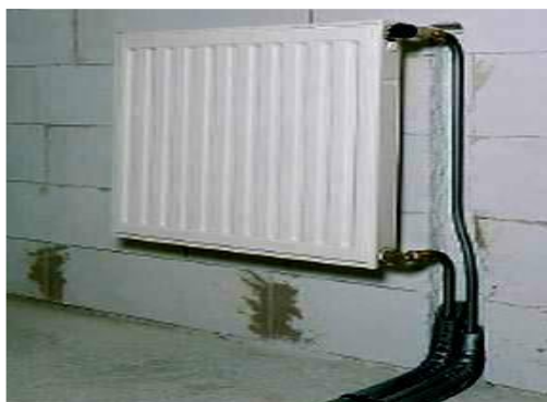
Fig. 11.12 – Variante pentru conectarea laterală a radiatorului de la canalul de perete
