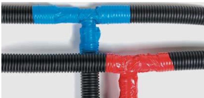
Fig. 11.1 – Protecția conexiunilor conductelor înainte de etanșare
