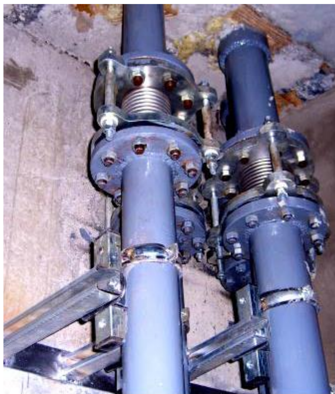
Рис. 11.3 – Пример установки сильфонных компенсаторов на стояках системы отопления
