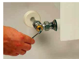
c – mod de setare prealabilă cu ajutorul unei supape de închidere-reglare
