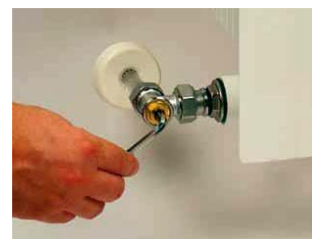
с – способ предварительной настройки с помощью запорно-регулирующего клапана
