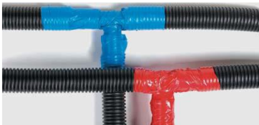
Рис. 11.1 – Защита соединений трубопроводов перед заделкой
