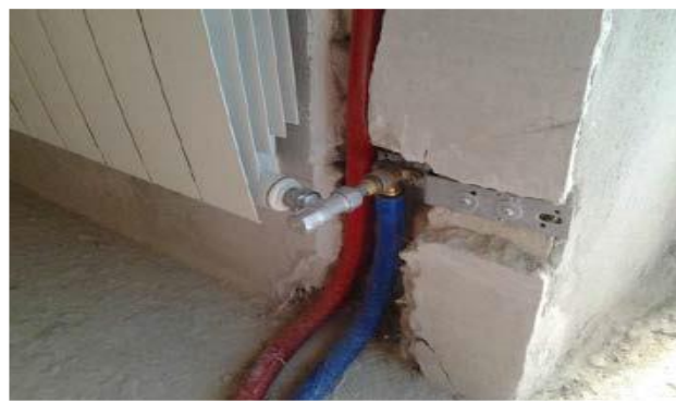
Fig. 11.12 – Variante pentru conectarea laterală a radiatorului de la canalul de perete
