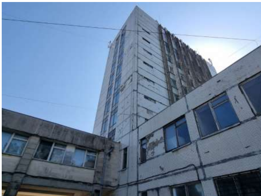
Figura12: Clădirea administrativă pe Campusul Mircești care va fi racordată la Parcul
