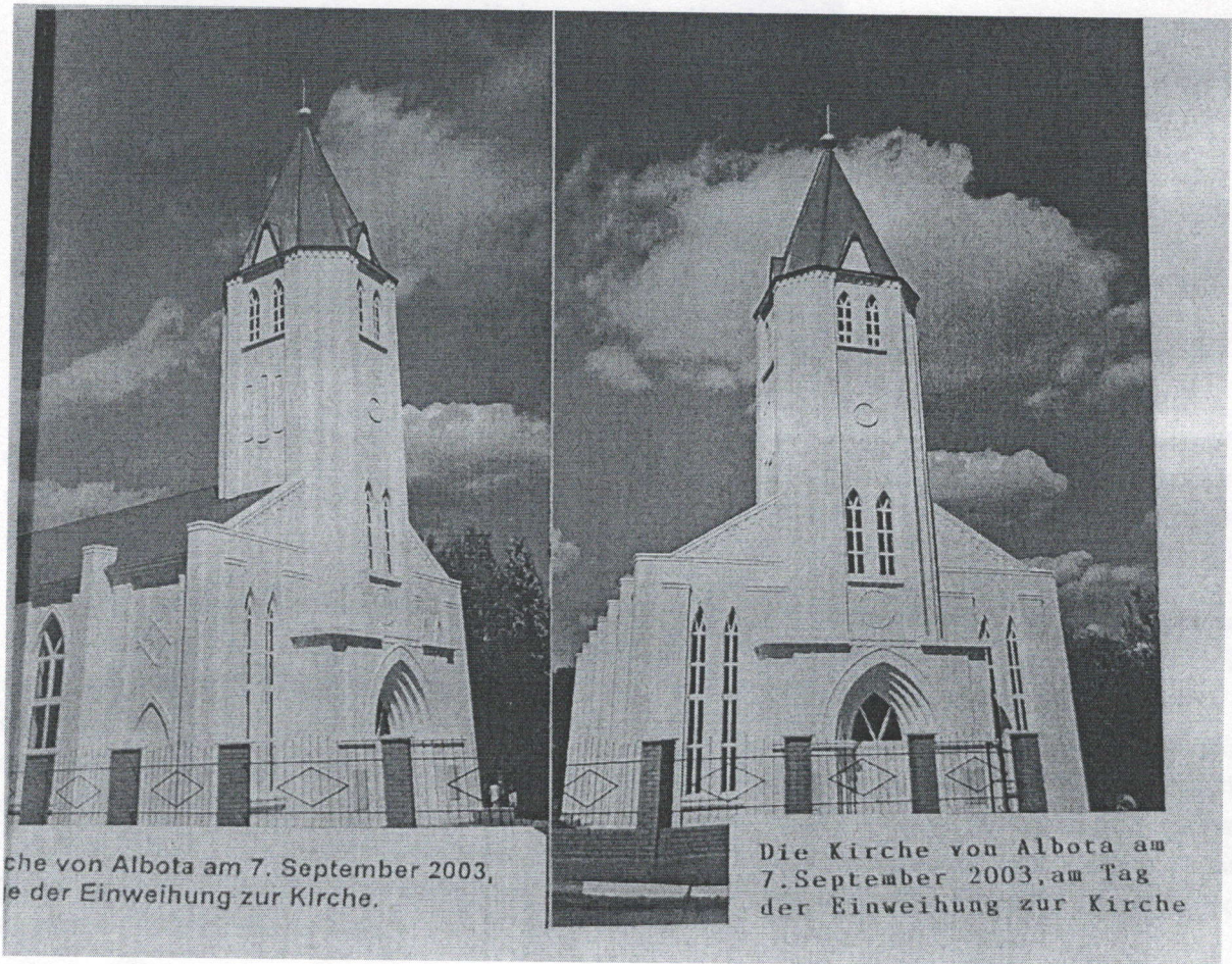
Вид здания после капитального ремонта и постройки колокольни.
