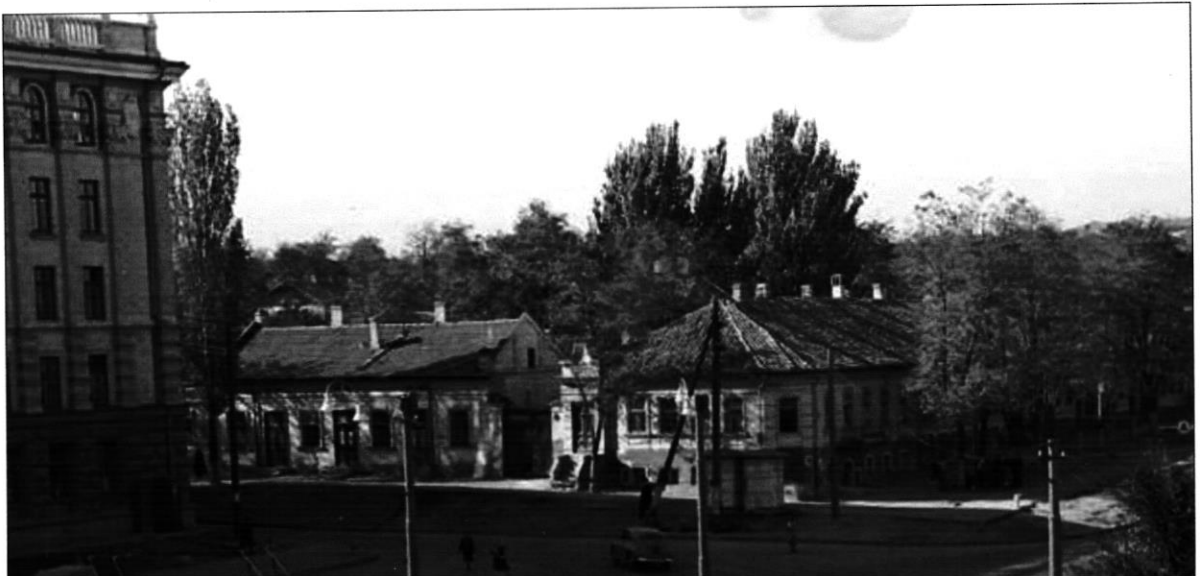
Clădirea AȘM în proces de construcție
