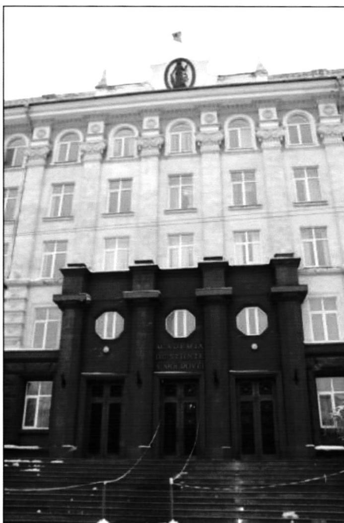
Accesul principal în clădirea AȘM
