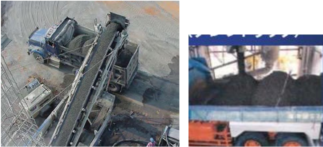
Рисунок 15 – Загрузка грузовых автомобилей смесью RCC
