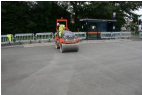
Рисунок 28 - Веревка прикатывается на месте образования деформационного шва.
