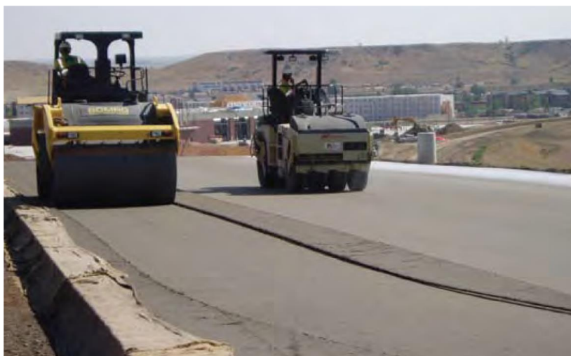
Figura 18 – Compactarea RCC cu un cilindru și rolă pneumatică
