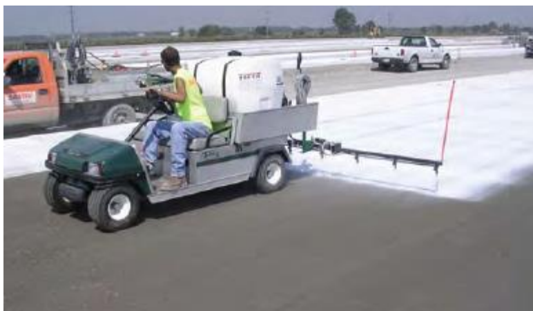
Рисунок 32 – Нанесение пленкообразующего материала
