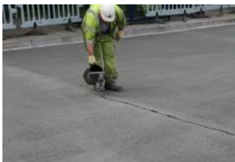
Рисунок 29 - Ручная заливка шва битумной эмульсией
