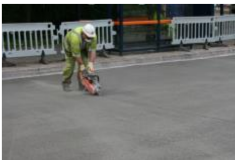
Рисунок 29 - Ручная резка шва сжатия
