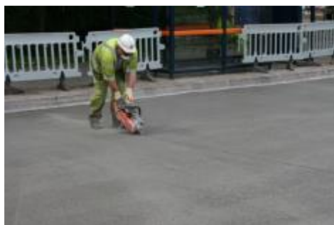
Figura 29 - Tăierea manuală a rostului de contracție
