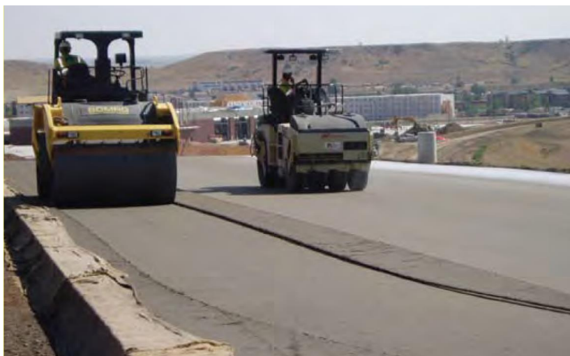
Рисунок 18 – Уплотнение РСС двухбарабанным вибрационным катком и катком на пневмошинах
