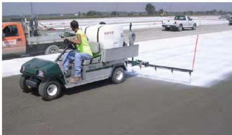
Figura 32 - Aplicarea materialului peliculogen
