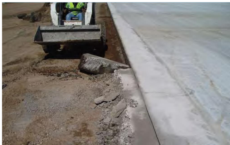
Figura 22 - Rostul longitudinal de construcție la rece finisat
