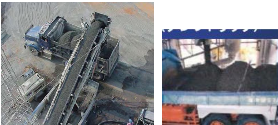
Figura 15 – Încărcarea camioanelor cu amestec RCC
