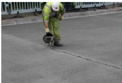
Figura 30 - Umplerea manuală a rostului cu emulsie bituminoasă
