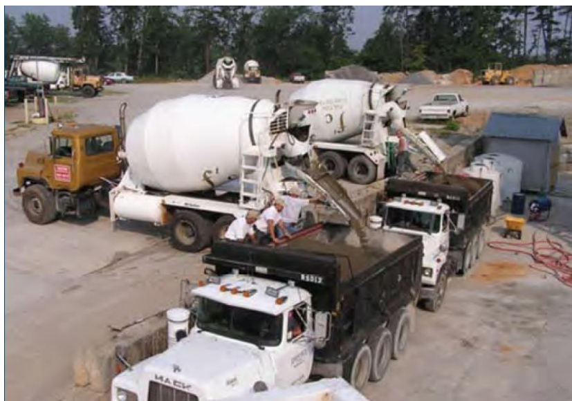
Figura 12 – Încărcarea camioanelor din autobetoniere
