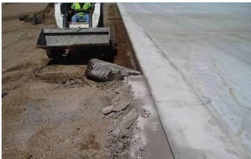
Рисунок 22 - Готовый холодный строительный продольный стык
