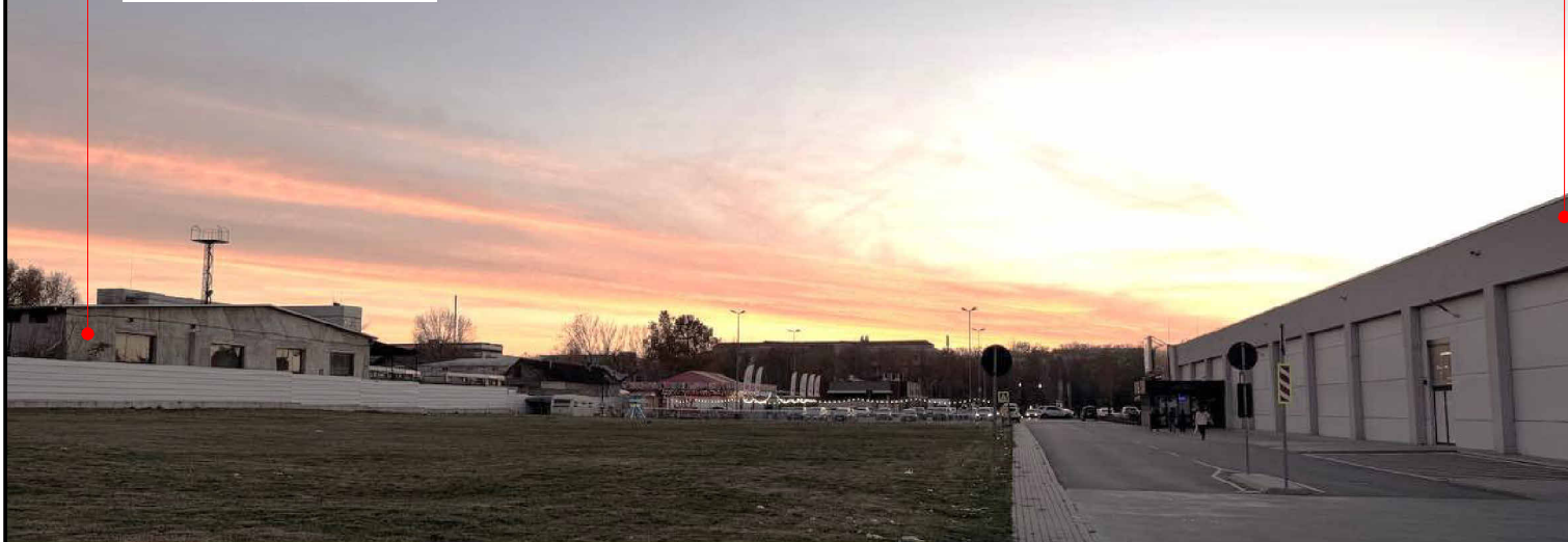
Foto 3 Clădire existentă cu nr. cadastral 0300203.346.02, Depozit. Structura: durabila, Starea: buna, Regim: P; H (estimativ) ≈ 7.0 m
